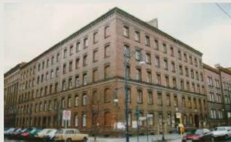
Schönhauser Allee/Buchholzer Straße, Zustand 1995
